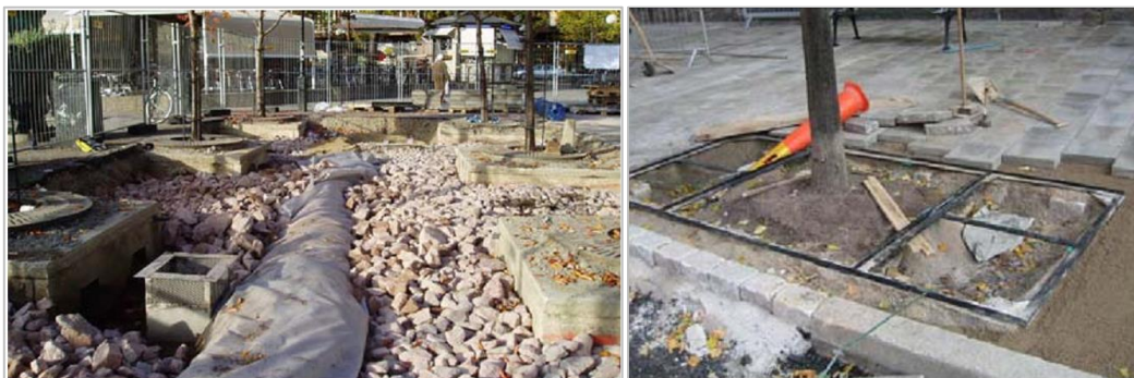
Figur 14. Makadamlager och utplacering av trädgallerram, foton: Björn Embrèn, Anders Ohlsson Sjöberg.
